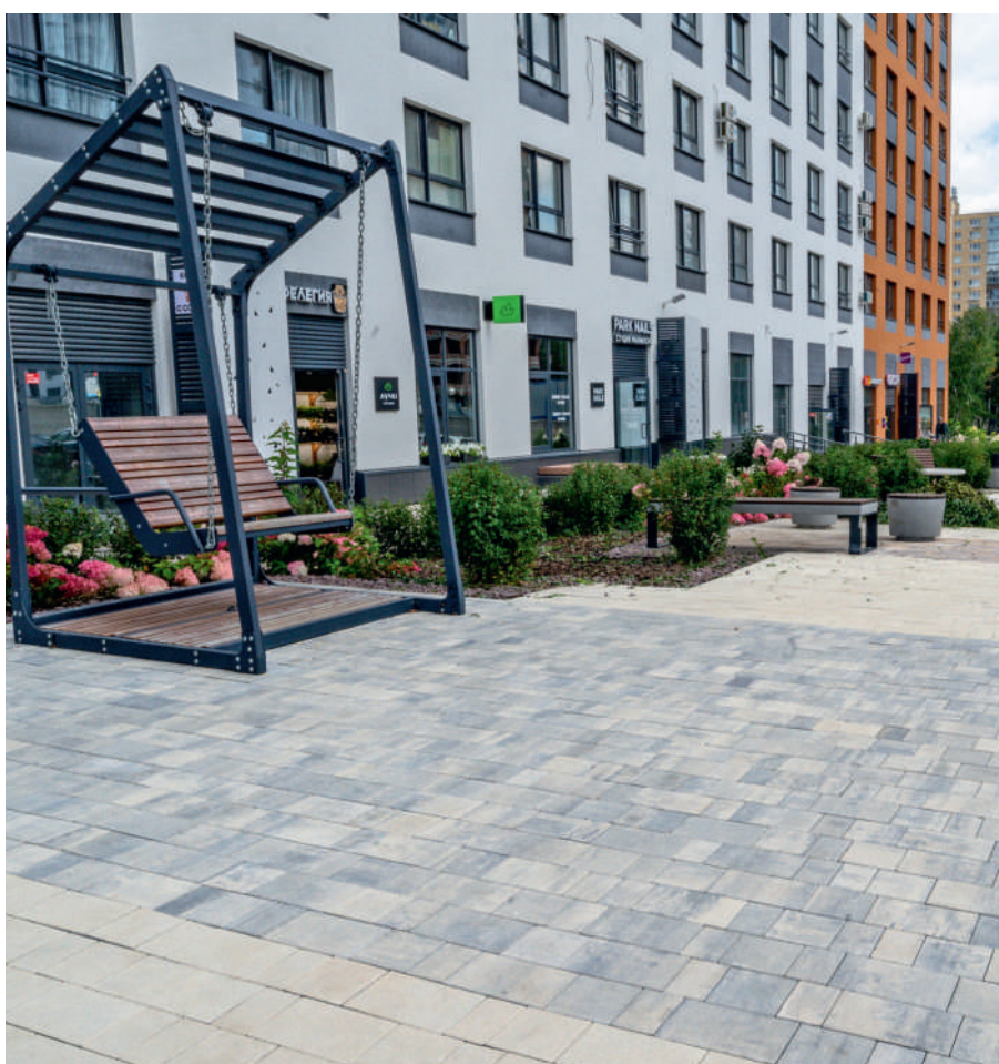
г. Челябинск, ЖК «Ньютон». Степняк. Базальт гладкий
